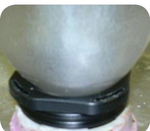
Instale la bomba al encaje, con el logo al frente. Para prevenir que la bomba se obstruya con residuos, asegúrese que el Adhesivo Fabtech 60 este completamente seco antes de activar la bomba.
